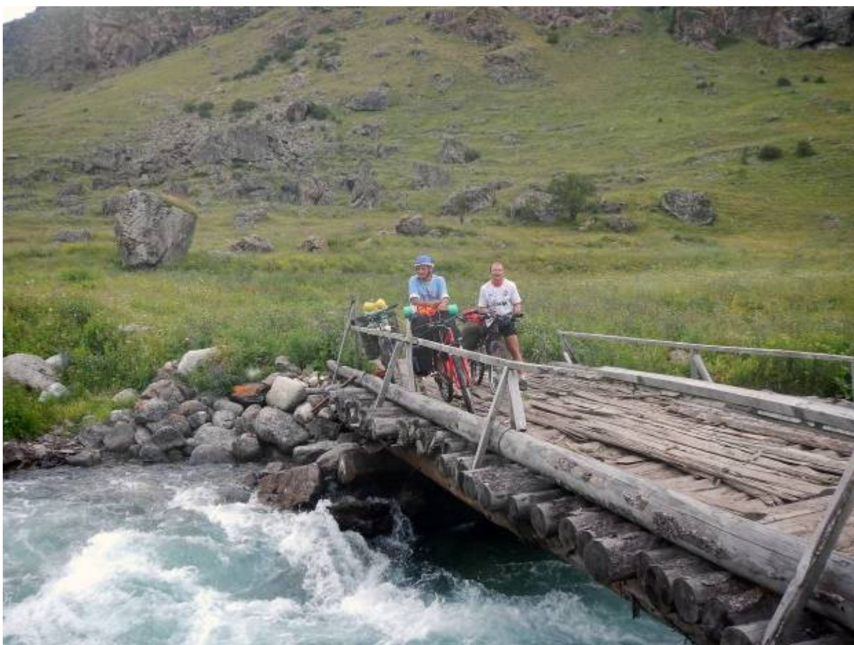
Фото № 24. Мост через р. Даут, развилка, едем в сторону пер. Ыбчик.
