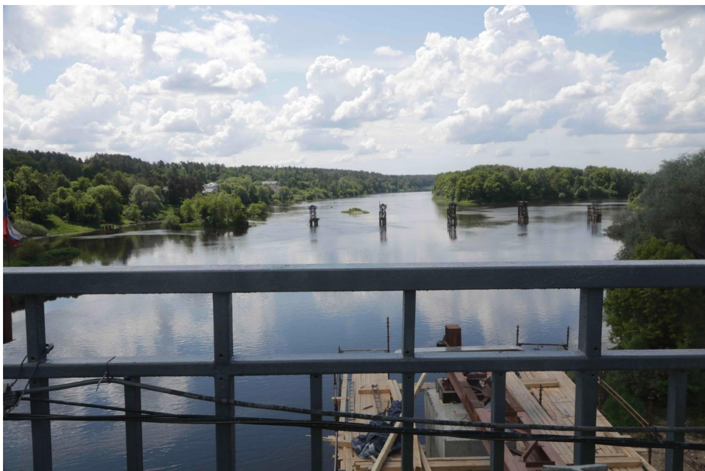
Фото: Мост через Клязьму трассы М7 - ближайший на маршруте после Владимира
