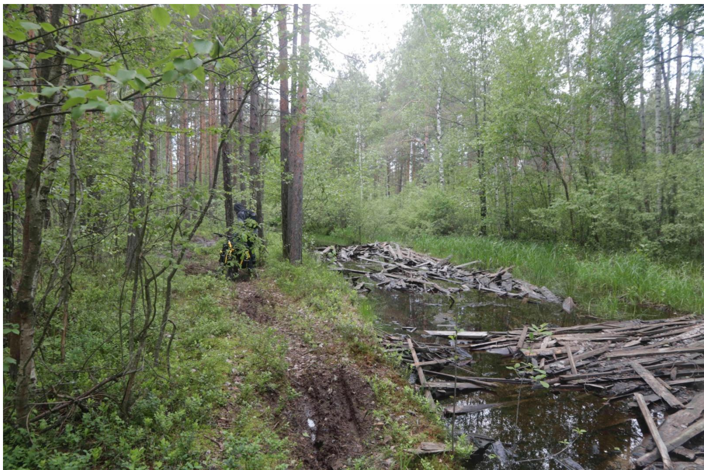
Фото: Подтопленная дорога на участке после Тасинского
