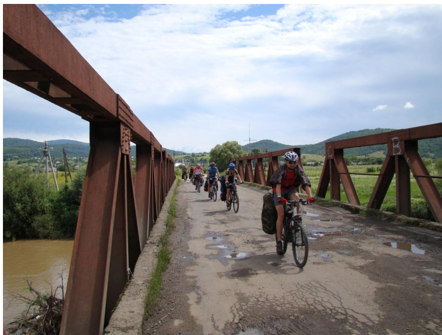
Фото 2.6. Мост через р. Уж перед выездом на дорогу местного значения Т-1403
